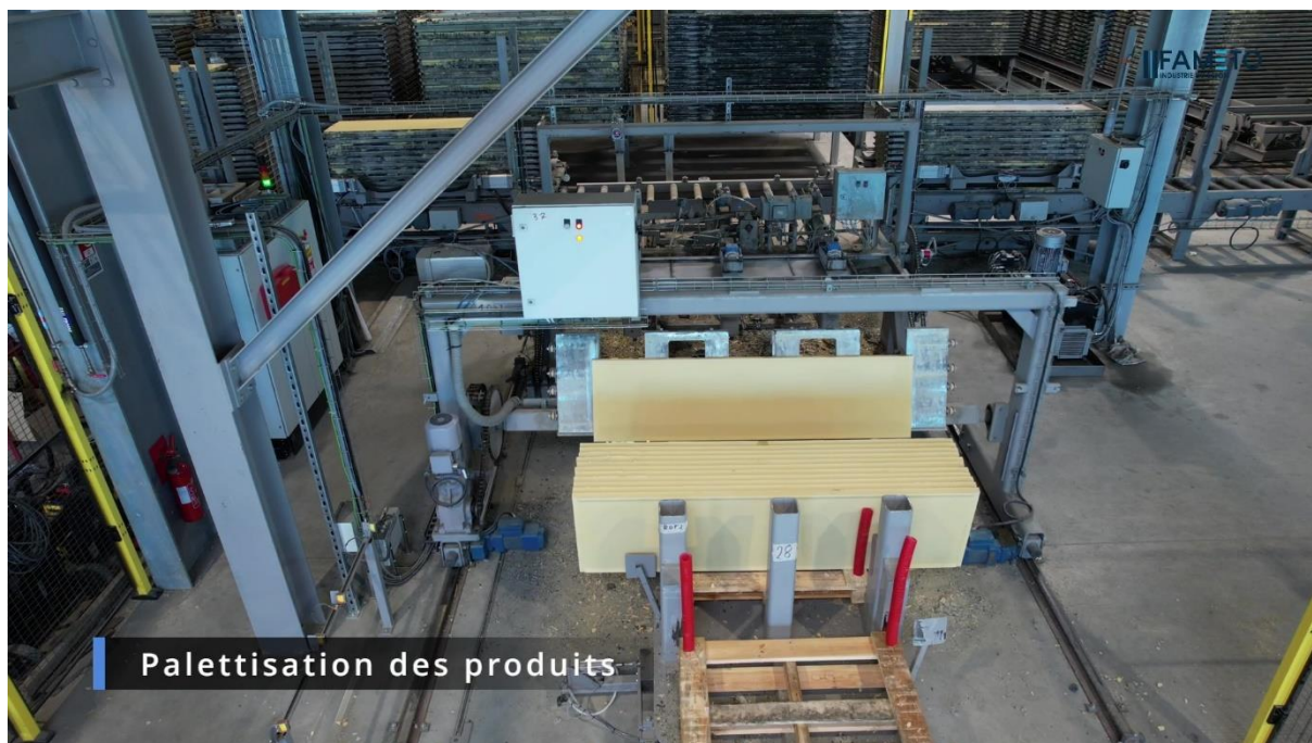
10. Ponte automatico per inserire i pallet in legno nelle stazioni di sformatura e gestire l'uscita dei pallet completi.
